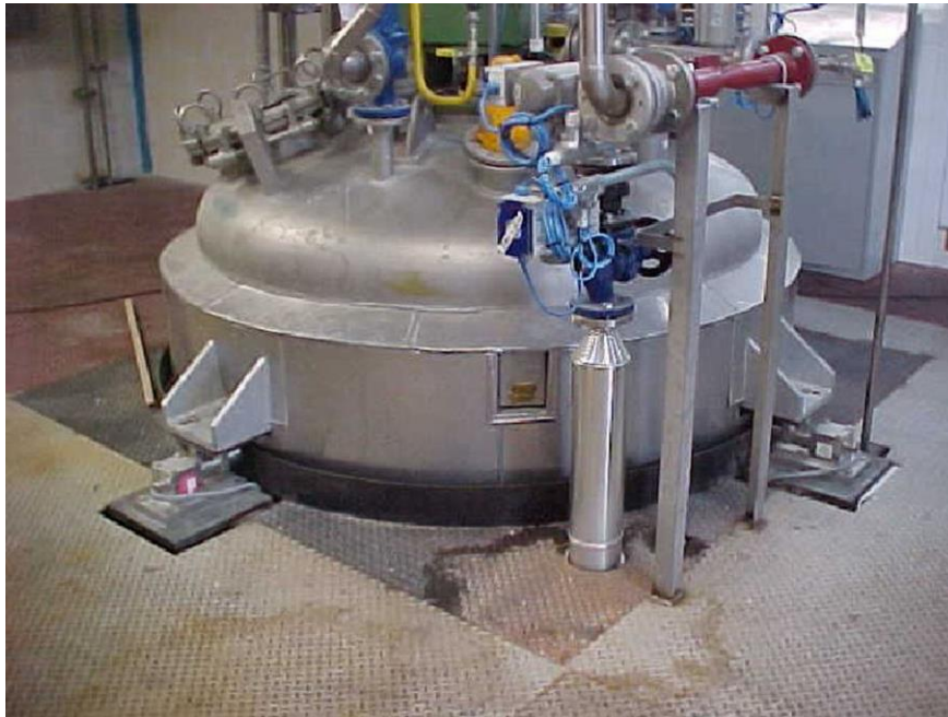
Figure 4: La cuve chauffée posée sur les KIS-8
